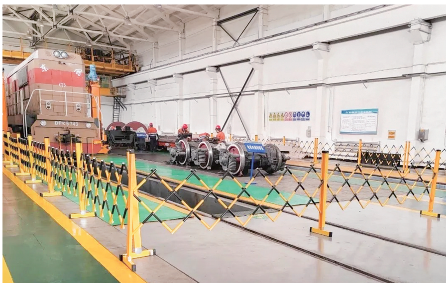
机车维修现场。
